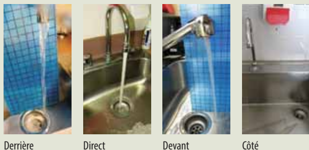
Figure 2 : Configurations possibles d'alignement robinet/drain
