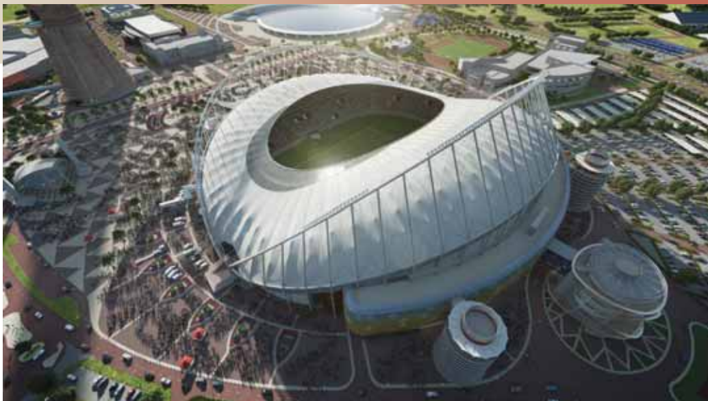
Le stade international Khalifa est en construction au Qatar.
