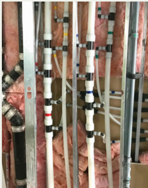
Système à quatre tuyaux
