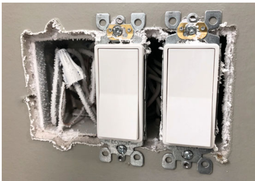
Scellement d'une boîte d'interrupteurs
