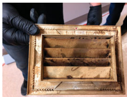
Nettoyage des grilles
