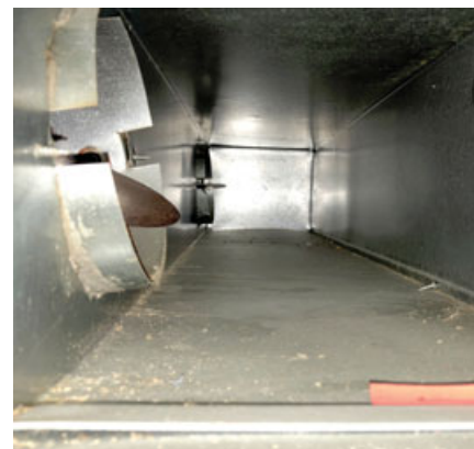
Inspection des conduits
