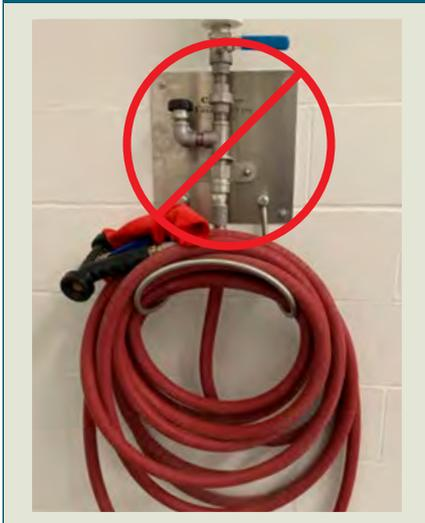
Schéma 6 : Tuyau d'arrosage avec brise-vidé
