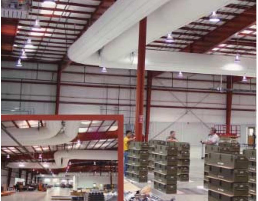
Il est possible de réaliser quantité de raccords et de changements de direction même en tissu.
