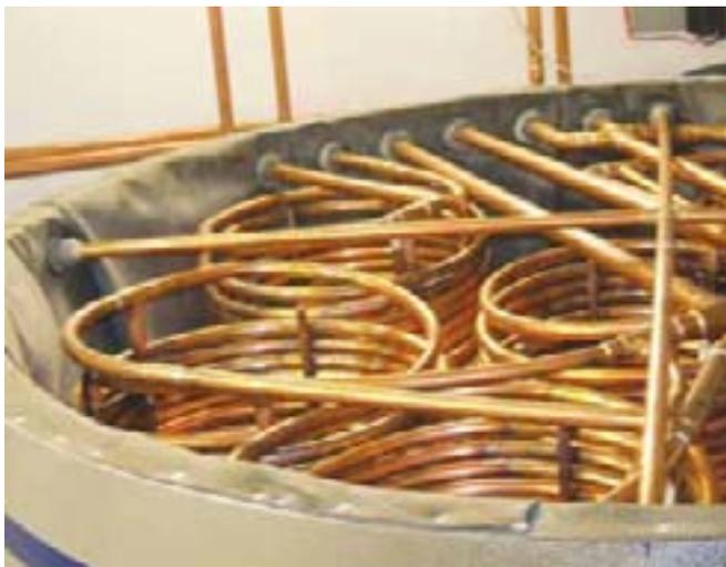
Le réservoir d'accumulation de 738 gallons US d'eau stagnante contient un serpentin central primaire de glycol constitué de 2 spirales de 3/4 po x 90 pi (pour minimiser la perte de charge). En périphérie, 3 serpentins secondaires sont dédiés au chauffage de l'eau sanitaire et 3 autres au chauffage des locaux. Dans ce type de réservoir, l'échange thermique est optimisé par la stratification, le contenu d'eau stagnante ne circulant pas.
