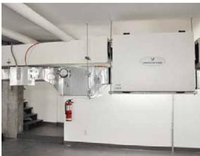
*Le VRC Venmar distribue les débits d'air requis par la norme Novoclimat dans chaque logement. L'air vicié des logements n'est pas recirculé afin de ne pas propager les odeurs de cuisson. Un chauffe-conduit électrique préchauffe l'air de ventilation si nécessaire et évite les cycles de dégivrage.*
