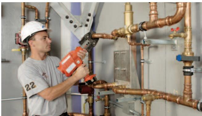
Exemples d'assemblages réalisés par sertissage
