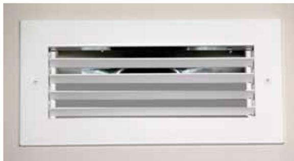
Grille d'alimentation avec un blocage pour réduire la superficie de sortie d'air.
