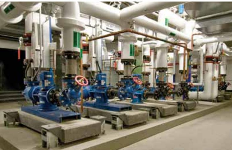
de ce projet de bâtiment en hauteur. Dès que la dalle de béton de l'avant-dernier étage a été coulée, la station totale a été utilisée pour le manchonnage afin de délimiter, selon les plans détaillés, les emplacements des équipements requis. Des grues ont installé toutes les pièces d'équipements. Cette opération a été répétée pour la salle mécanique du dernier étage.
