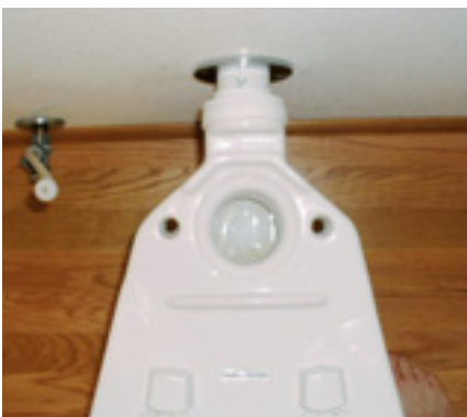
Le raccordement du canal d'aération au ventilateur est la principale différence visible de la cuvette; une fois le réservoir installé, on ne le voit plus.
